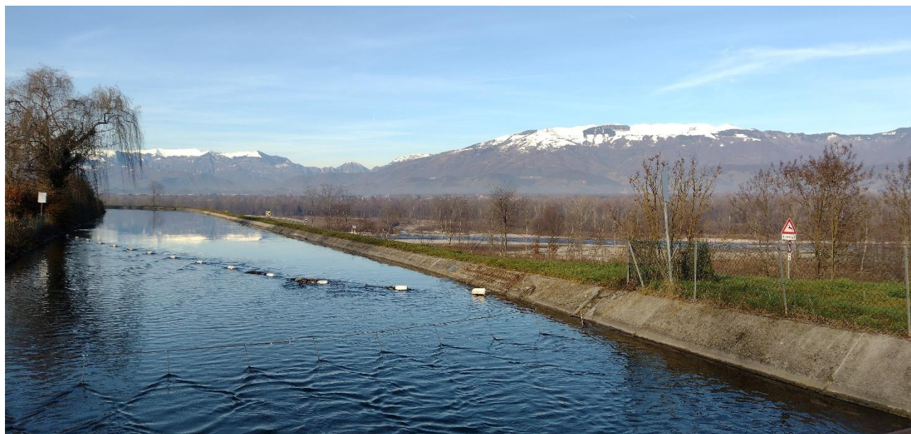
Canale "Castelviero" per derivazione idroelettrica con vista sul fiume Piave e le Prealpi trevigiane (credits: Nico Dalla Libera)
