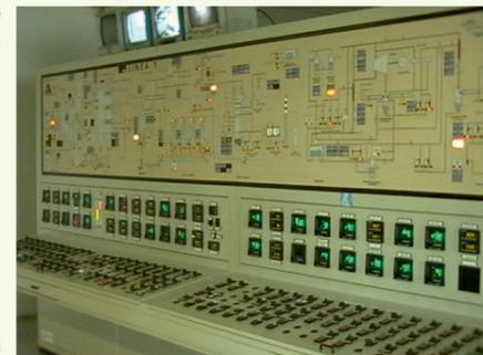
Pannello di controllo del termovalorizzatore
