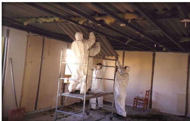
4. Appoggiare le lastre, le canne fumarie, vasche e simili altro materiale contenente amianto sul pallet preparato con il telo in polipropilene e completare integralmente l'applicazione del prodotto incapsulante in modo che tutta la superficie sia trattata.
