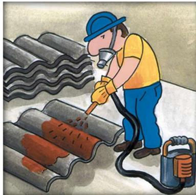
2. **Cospargere tutta la superficie visibile con il prodotto incapsulante prima di rimuovere o spostare le lastre o i manufatti in modo da evitare qualsiasi dispersione di fibre e polveri di amianto nell'ambiente circostante. Il materiale può essere rimosso quando si presenta asciutto in superficie (dopo circa 1 ora).**
