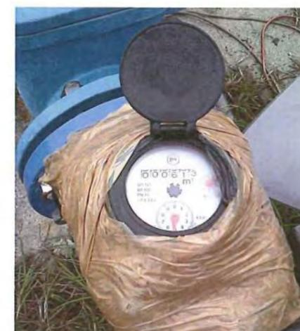
Nuovo contatore delle acque meteo scaricate a depuratore
