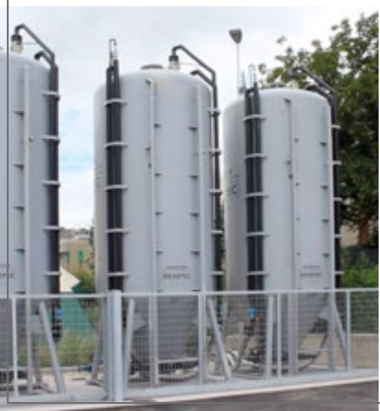
Medio Chiampo Filtrazione anti PFAS a Zermeghedo (VI)
