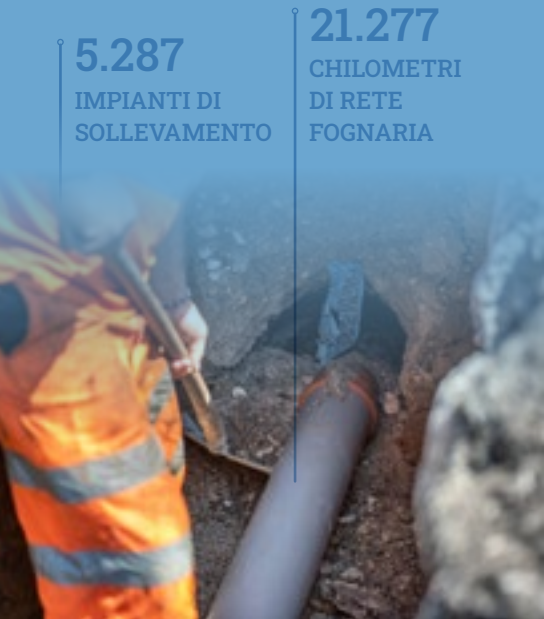
📷 Viacqua Cantiere separazione reti fognarie Dueville (VI)
