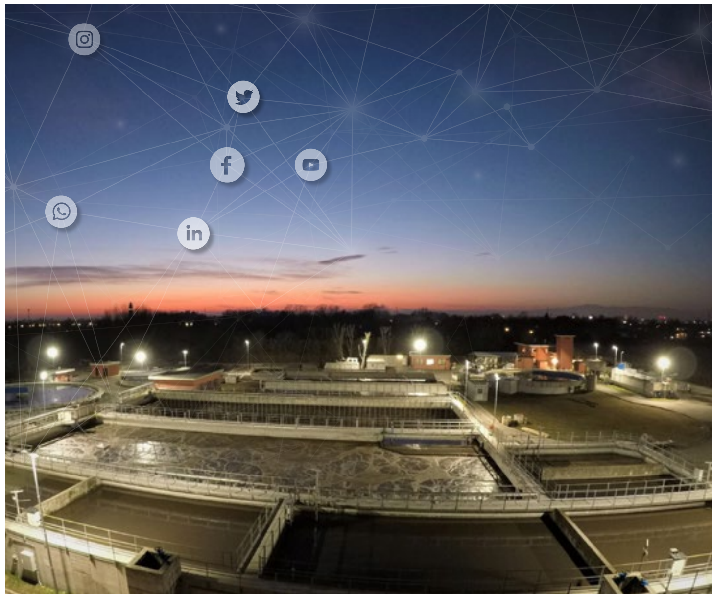
ATSS Depuratore di Treviso (TV)
