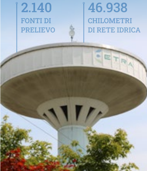
📷 Etra Torre piezometrica della centrale idrica Piombino Dese (PD)
